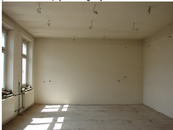
pomieszczenie piętro II- z grzejnikami
